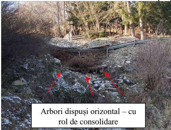
Fig. 5 – Arbori dispuși in corpul drumului
