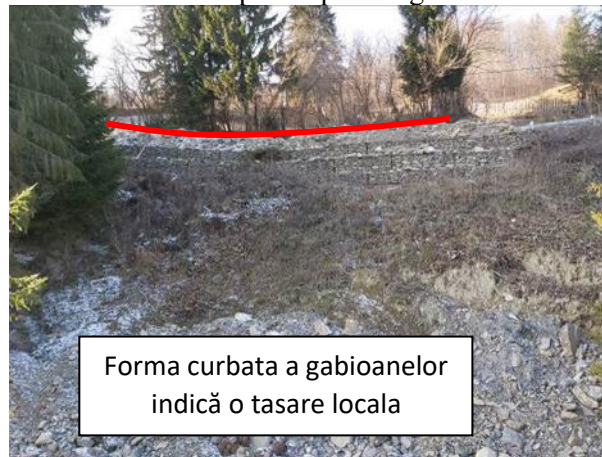
Fig. 8 – Tasare la nivelul gabioanelor
