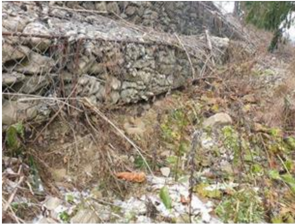
Fig.3-Structura din gabioane
